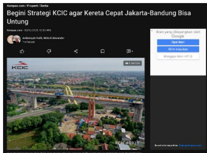
Gambar 1.8 KCIC Menuntaskan pekerjaan Konstruksi
