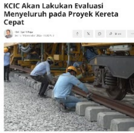
Gambar 1.4 Konsorsium kontraktor proyek Kereta Cepat Jakarta-Bandung menyelesaikan pemasangan rel yang akan digunakan untuk uji dinamis menjelang gelaran G20. (Foto: Antara)
