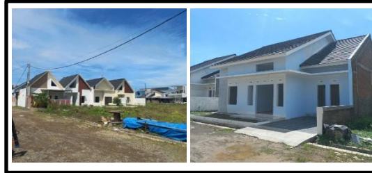
Gambar 7. Kondisi Fisik Perumahan Graha Sudirman Cluster Alamanda
