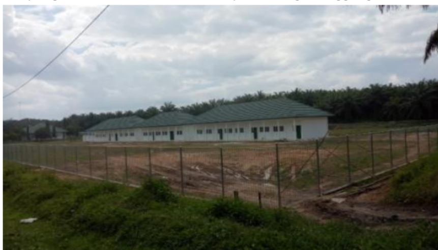
Gambar 4. Dokumentasi pembangunan gedung SMK Negeri 2 tahun 2020
