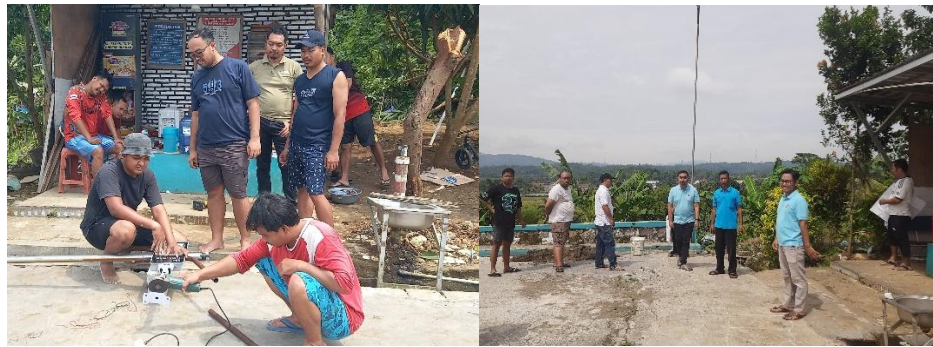
Gambar 4. Kegiatan Pemasangan Lampu Panel Surya Bersama Warga
