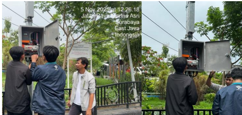
Gambar 5. Pemasangan Modular Smart PJU di Terminal Keputih
