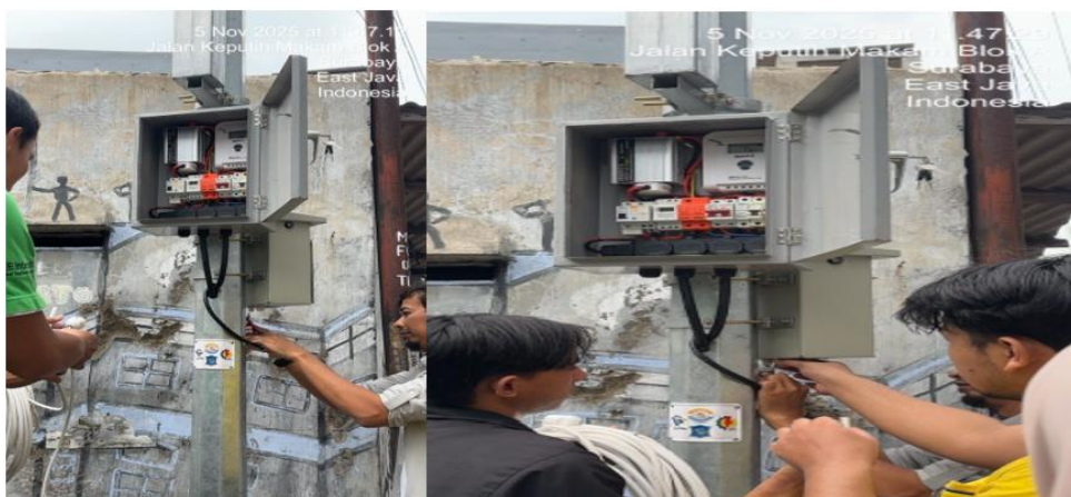
Gambar 4. Pemasangan Modular Smart PJU di Gang Makam Keputih
