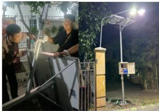
Gambar 8. Proses Pemasangan Modular Smart PJU
