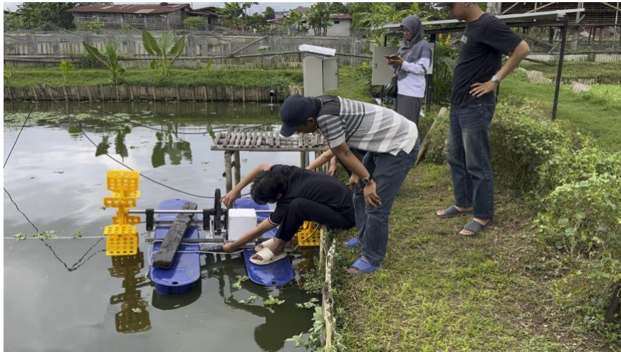
Gambar 4. Instalasi dan Uji Coba Aerator dan PLTS
