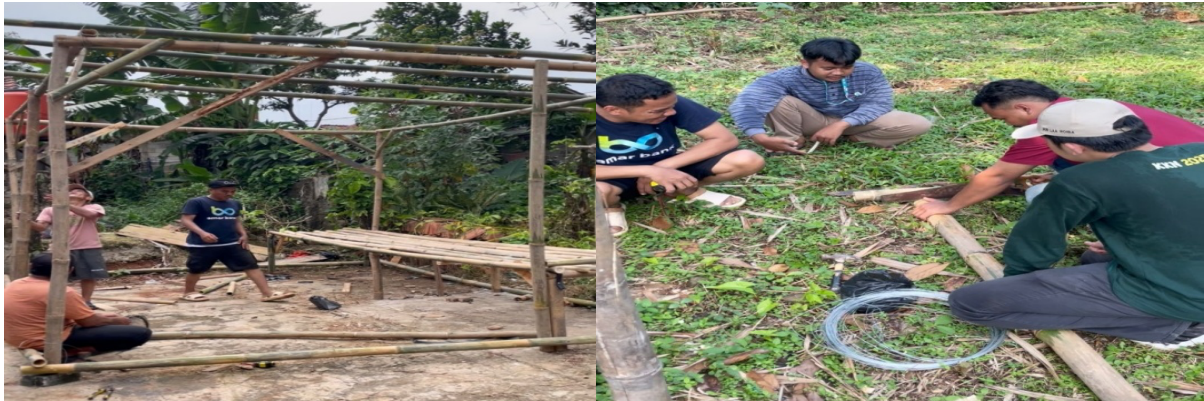
Gambar 3. Tahapan Pondasi Pembangunan Green House Hidroponik
