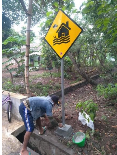
Gambar 2. Rambu Bencana Rawan Banjir Sumber: BPBD Kabupaten Jombang, 2023
