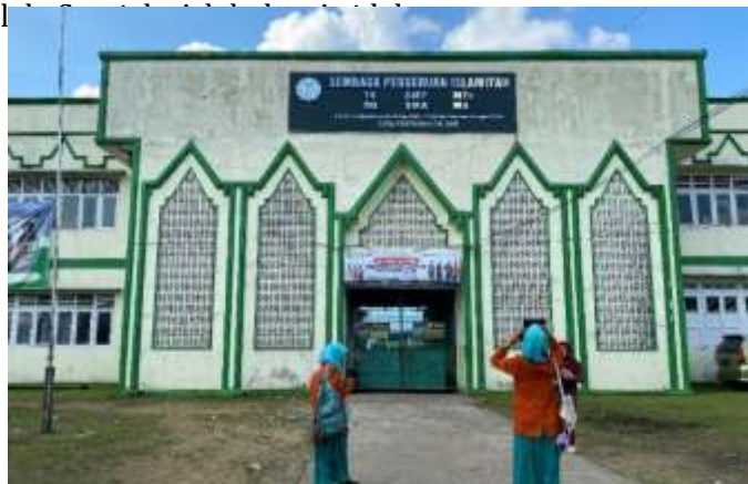
Gambar 1. Tampak Depan Bangunan Yayasan Perguruan Islamiyah
