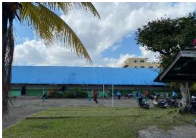
Gambar 3. Bangunan sekolah jenjang SD di Yayasan Perguruan Islamiyah
