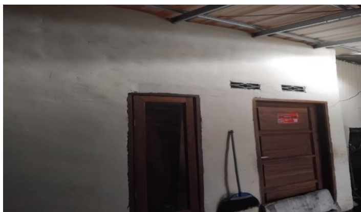
Gambar 7. Gambar Rumah Sesudah di Renovasi
