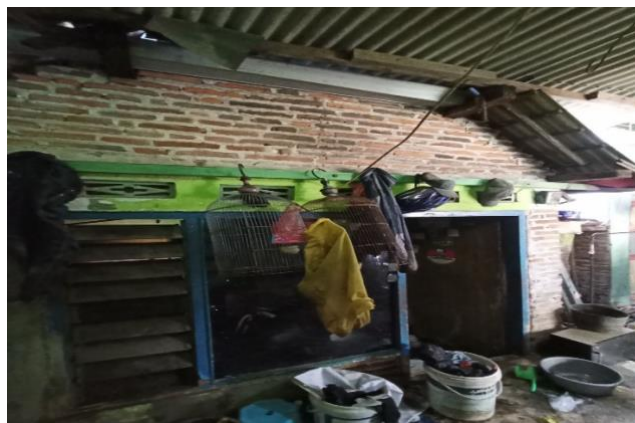
Gambar 6. Gambar Rumah Sebelum di Renovasi
