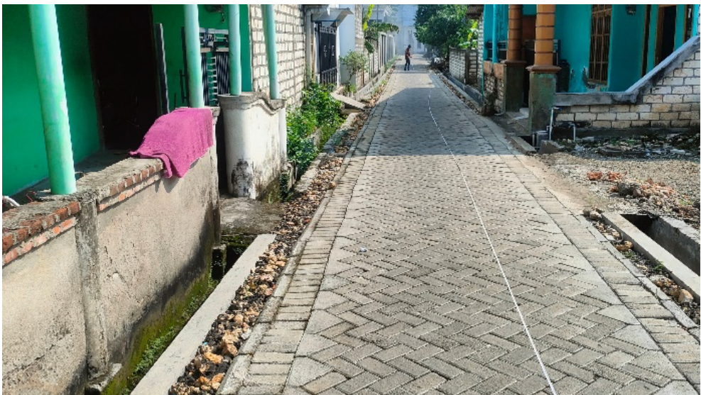
Gambar 2. Dokumentasi Bantuan Pembangunan PSU pada Jalan Paving di Bondowoso
