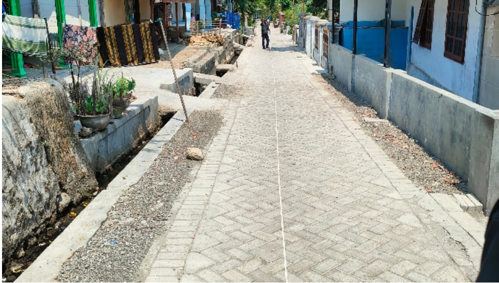
Gambar 1. Dokumentasi Bantuan Pembangunan PSU pada Jalan Paving di Lamongan
