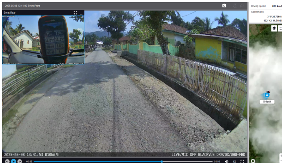
Gambar 3 (a) Ruas Jalan Bukit Ulu – Bukit Layang STA 0 + 120
